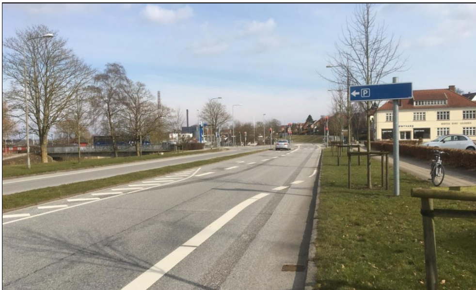
Foto: Henning Lausten, marts 2018
