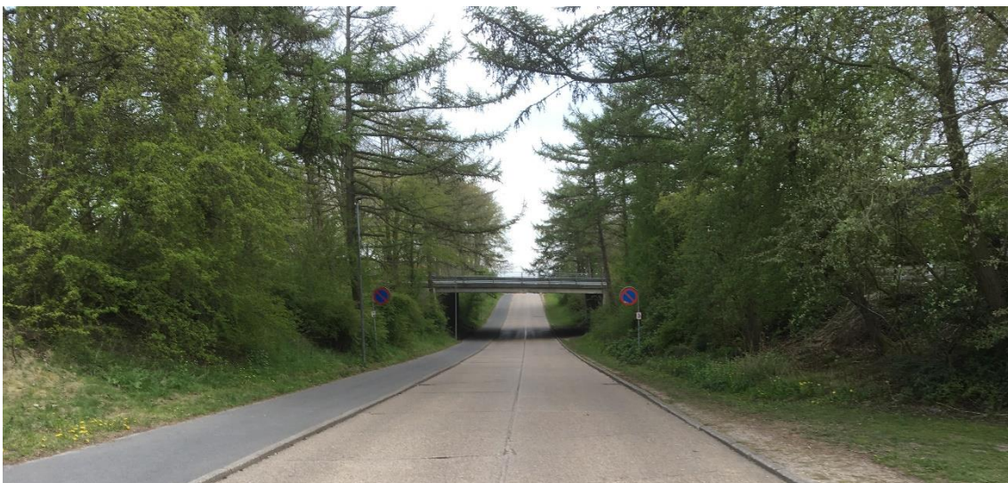
Foto: HL 4.5.23. Louisevej nord for Omkørselsvejen. Der laves ny fællessti i højre side.
