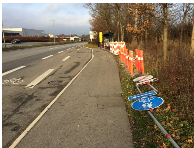
Ombygningen af busperronen på Brønsholm Kongevej (øst for Rema1000) er blevet påbegyndt i starten af december.
